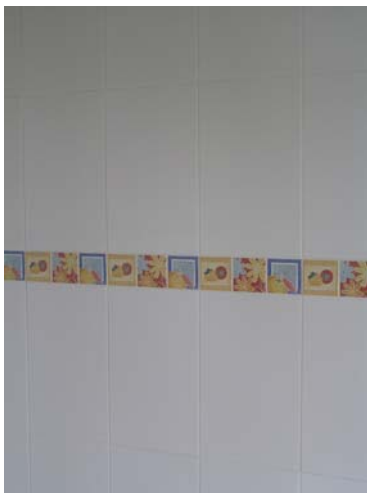
Alicatado en cocina
